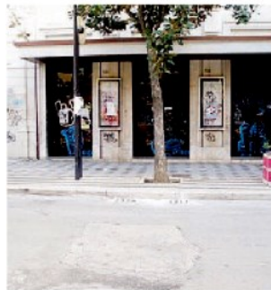
TEATRO ASTRA L'ingresso della struttura chiusa da dieci anni ad Andria
